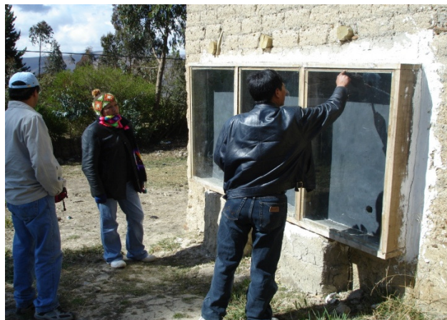
Muros Trombe contruidos por OPS en la localidad de Cuyuni, provincia de Quispicanchis, Cusco
