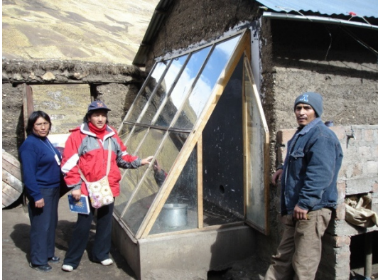
Muros Trombe encontrados en Huachocolpa, Huancavelica; ¿caso piloto del MVCS?
