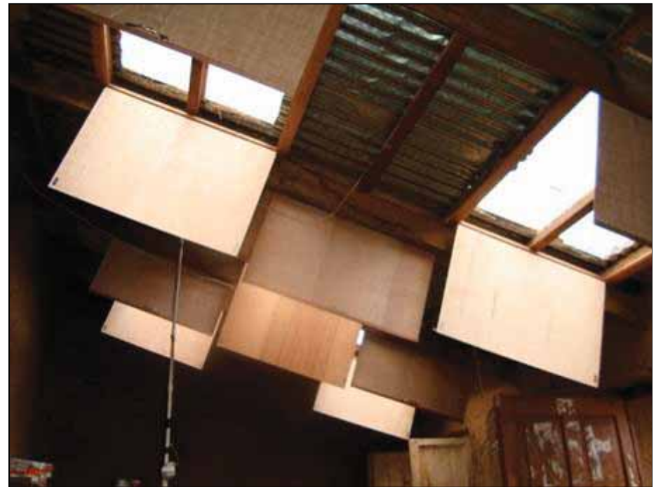
Compuertas aislantes termicas para reducir las perdidas por conduccion en la noche
